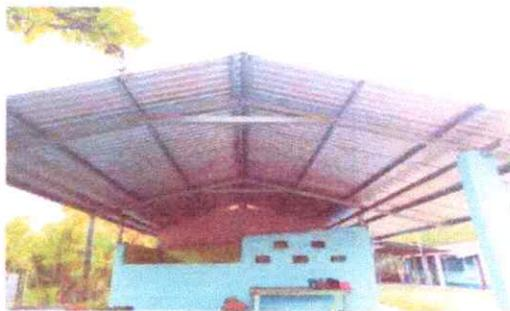
Foto 5: De mediana distancia que muestra que muestra el techo de lamina zinc ya instalado en la cocina.
