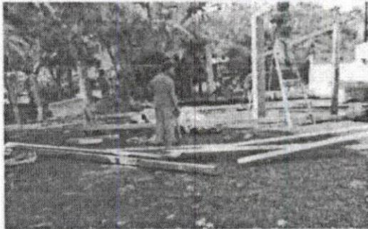
Foto 1: De mediana distancia que muestra costaneras que seran soldadas en el techo de la cocina.
