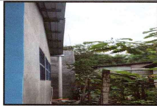
Foto 18: Sustrucción de bajada de agua pluvial de metal por tubo PVC 3"
