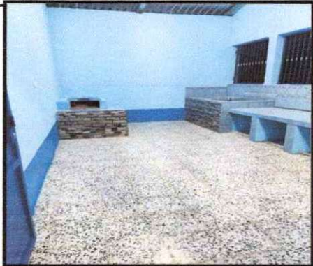
Foto7: Reparación de piso de granito en cocina
