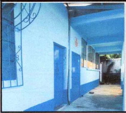
Foto 19: Aplicación de pintura en paredes interiores y exteriores
