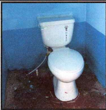
Foto 21: Sustitución de inodoro
