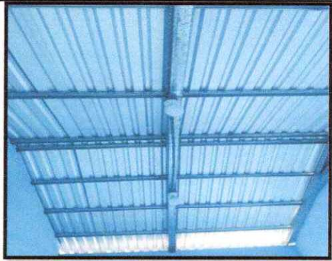
Foto 1: Sustitución de lámina por lámina troquelada aluzinc calibre 26 en cocina
