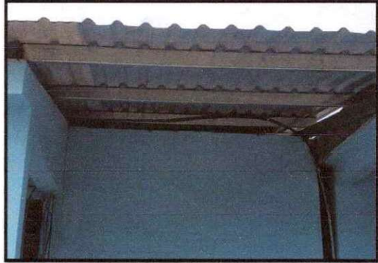
Foto 14: Sustrucción de estructura de soporte de madera por metal en baño y bodega
