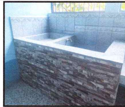
Foto 24: Instalación de pila y 1 lavadero en cocina
