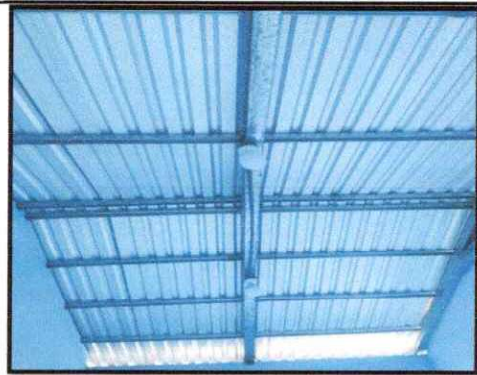
Foto 2: Instalación de lámina troquelada aluzinc en cocina
