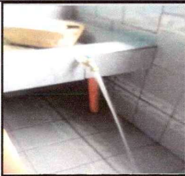
Foto 23: Instalación de tubería para agua potable
