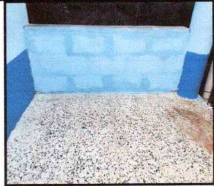
Foto 26: Muro de contención
