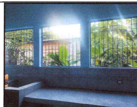
Foto 6: Sustitución de balcones de metal en cocina
