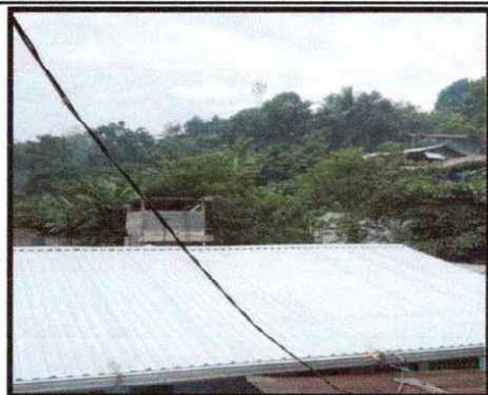
Foto 11: Reparación de cableado eléctrico
