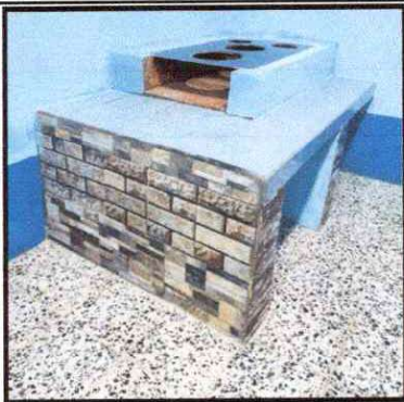
Foto 27: Sustrucción de azulejo en estufa rural completa (plancha y chimenea)
