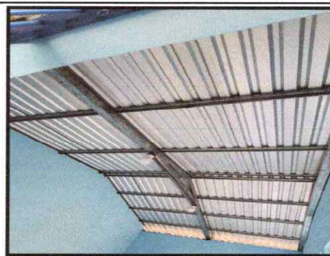
Foto 4: Instalación de Estructura portante
