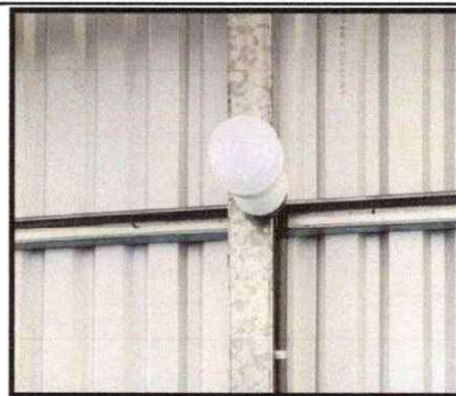
Foto 12: Sustitución de plafoneras
