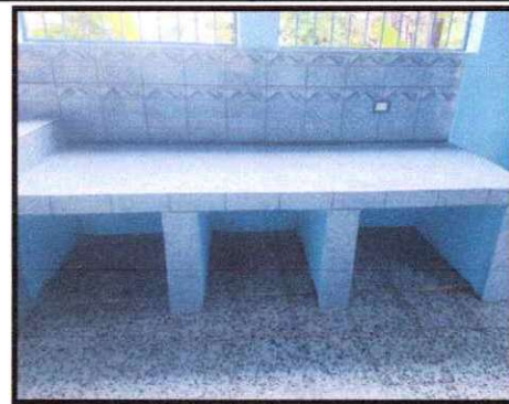
Foto 22: Sustitución de azulejo
