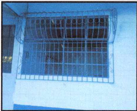
Foto 17: Mantenimiento a balcones de metal
