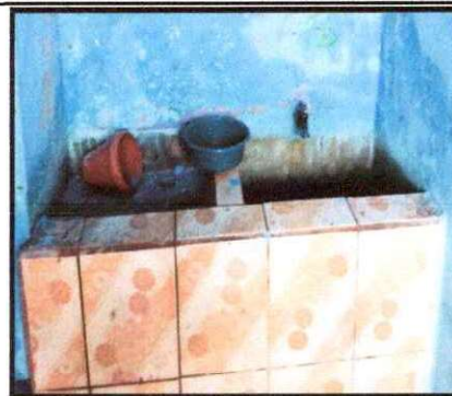
Foto 28: Instalación de azulejo en pila de baños
