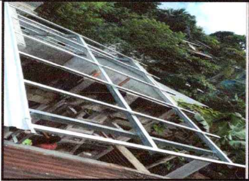
Foto 4: Instalación de Estructura portante
