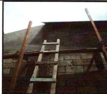
Foto 8: Repello en paredes de cocina
