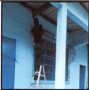
Foto 17: Mantenimiento a balcones de metal
