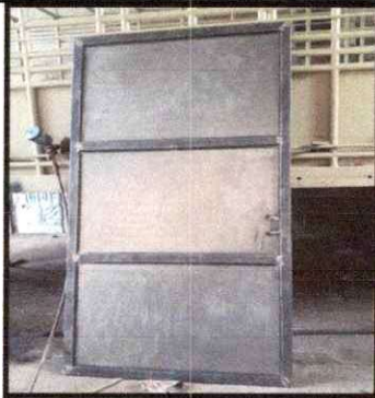
Foto 5: Sustitución de puerta en cocina
