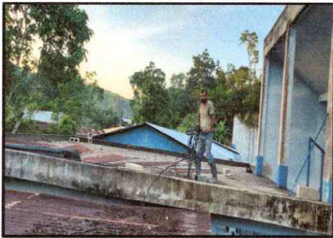
Foto 11: Reparación de cableado eléctrico
