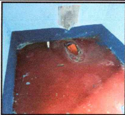
Foto 21: Sustitución de inodoro
