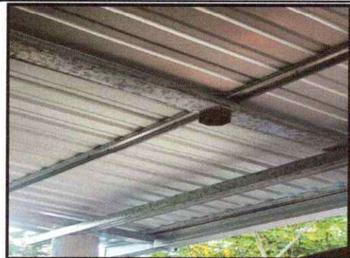
Foto 2: Instalación de lámina troquelada aluzinc en cocina
