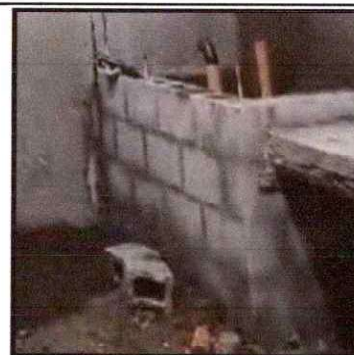
Foto 24: Instalación de pila y 1 lavadero en cocina
