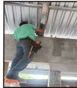
Foto 12: Sustitución de plafoneras
