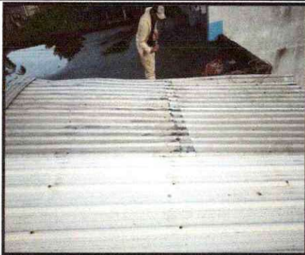
Foto 15: Sustrucción de lámina aluzinc
