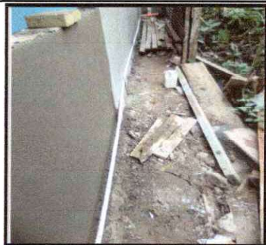
Foto 23: Instalación de tubería para agua potable
