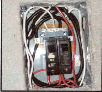
Foto 13: Sustrucción de tableros de filipones
