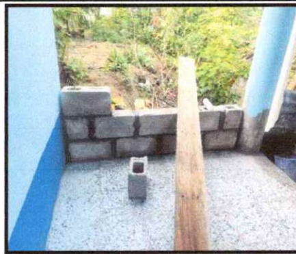
Foto 26: Muro de contención
