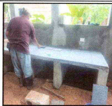
Foto 22: Sustitución de azulejo
