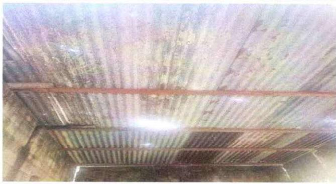
FOTO 1: CAMBIO DE LAMINA POR LAMINA DE ALUZIN.
