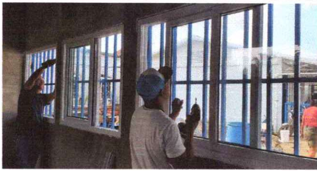
Foto 7: Sustitución de ventanas de madera por metal mas vidrio.
