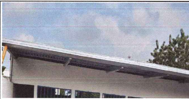
Foto 11: Sustitución de canal de metal.
