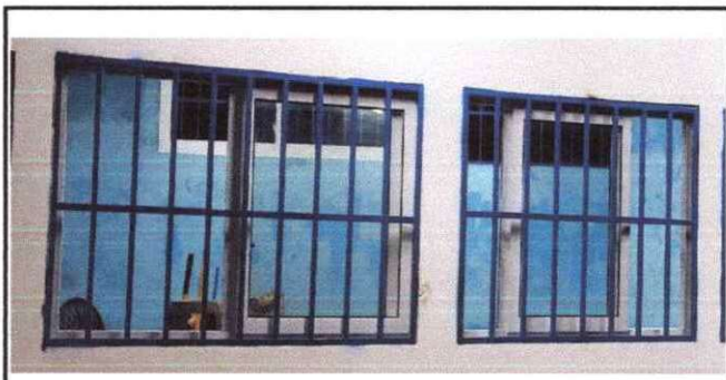
Foto 5: Sustitución de balcones de metal.
