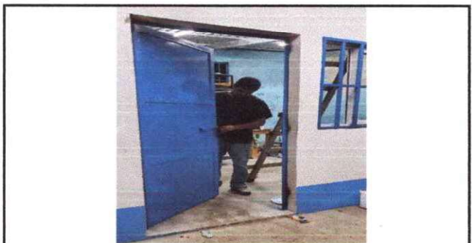
Foto 6: Sustitución de puerta.
