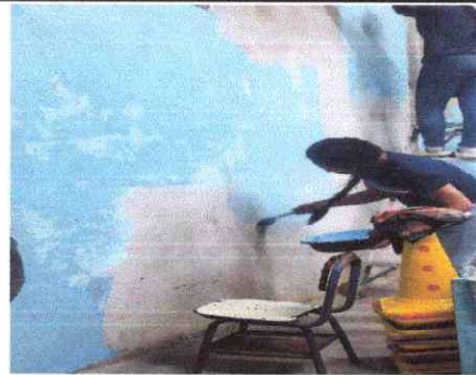
Foto 10: Pintura en muros exteriores e interiores.
