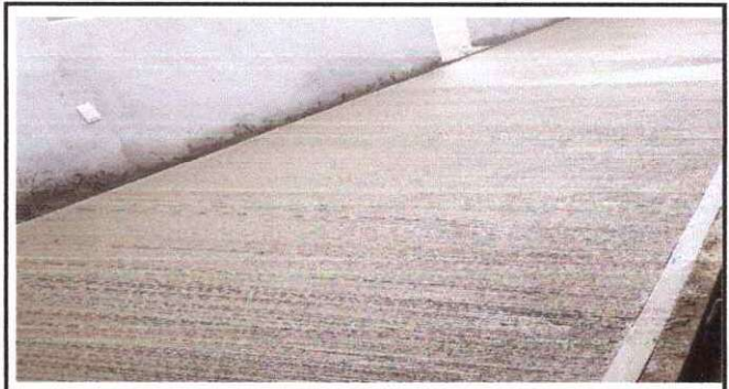
Foto 2: Sustitución de piso de torta de concreto.
