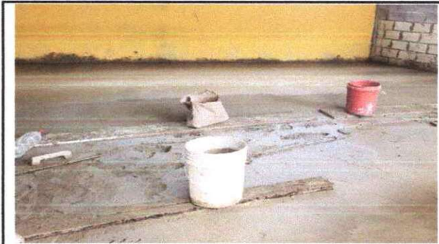
Foto 1: Sustitución de piso de torta de concreto.
