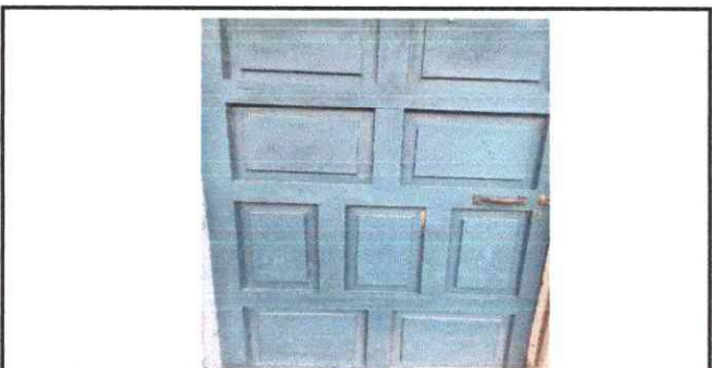
Foto 6: Sustitución de puerta.
