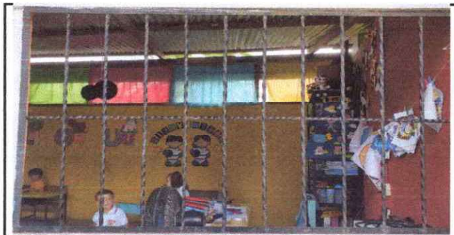
Foto 5: Sustitución de balcones de metal.
