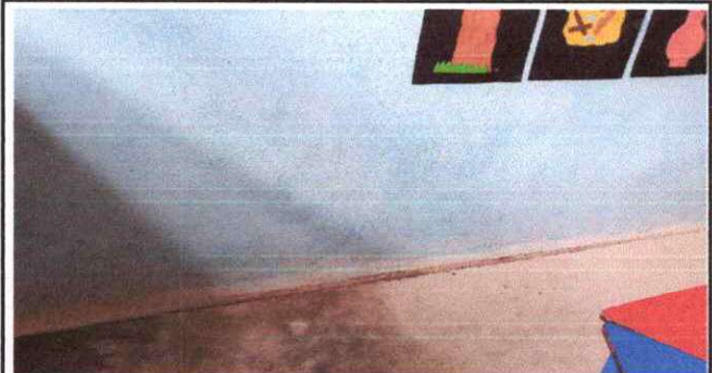
Foto 2: Sustitución de piso de torta de concreto.
