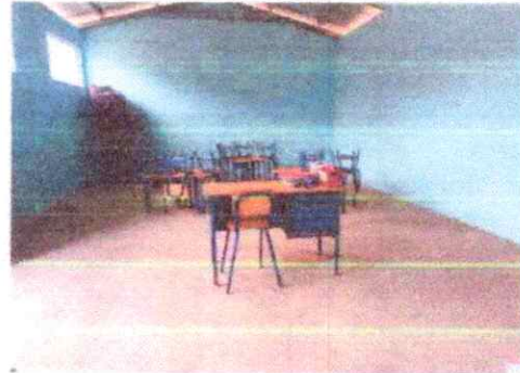
Foto 2: Piso de concreto terminada.
