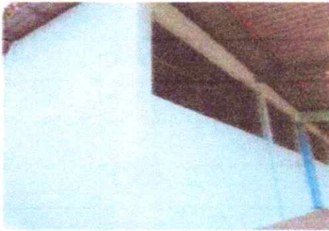
Foto 3: Mantenimiento de estructura
