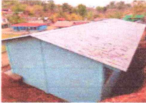
Foto 1: Mantenimiento de estructura y lámina
