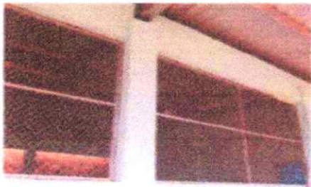
Foto 5: Mantenimiento de ventanas
