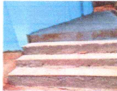
Foto 2: Reparación de banqueta
