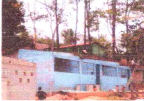
Foto 1: Desintalación de lámina
