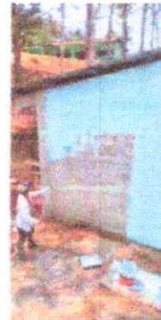
Foto 4: pintado de muro exterior e interior
