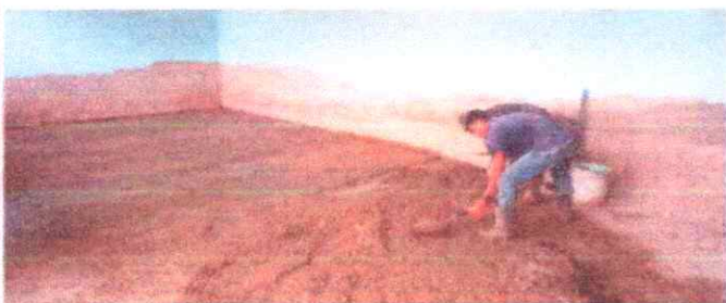
Foto 3: colocación de piso
