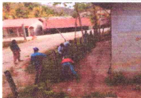
Foto 6: desintalación de maya de cerco.
