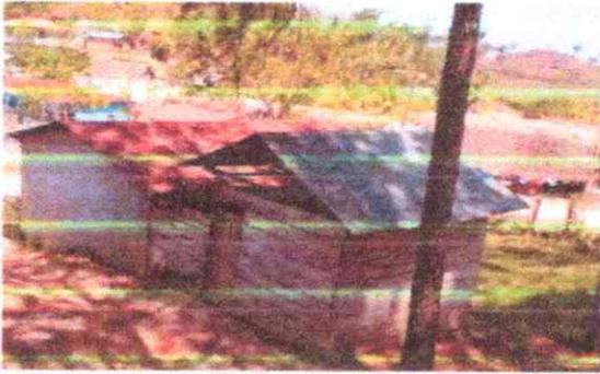
Foto 3. Sustitución de lámina, por lamina troquelada.
