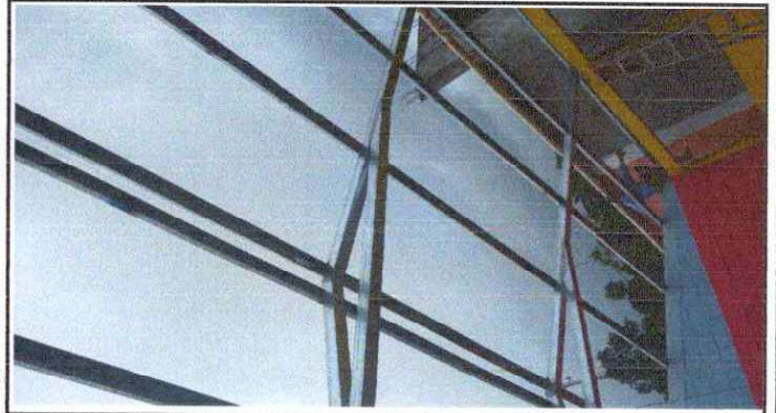
Foto 2: Sustitución de estructura de soporte de metal, por metal.
