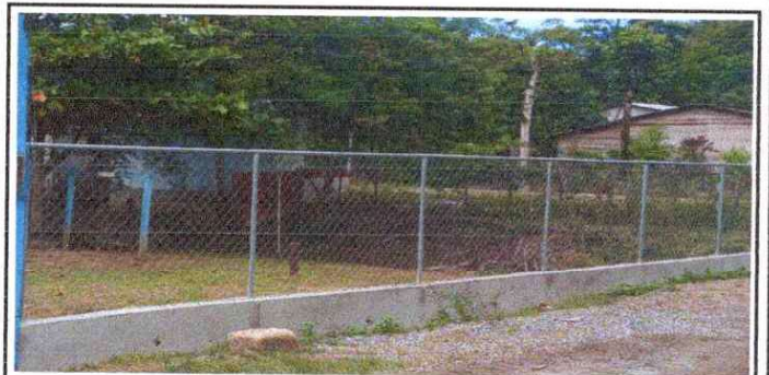
Foto 12: Reparación de muro perimetral de block
