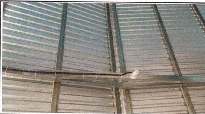
Foto 9: Reparación de cableado electrico.
