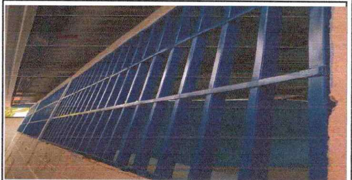
Foto 4: Sustitución de estructura de metal de ventana
