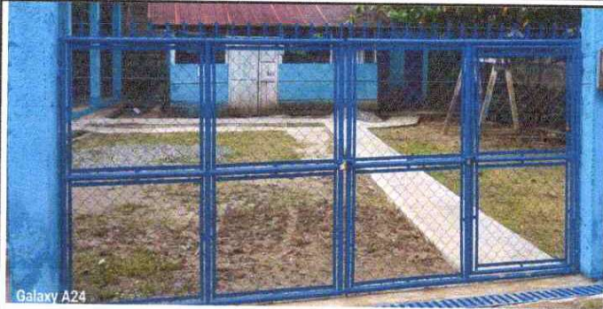
Foto 7: Mantenimiento a portones de metal.
