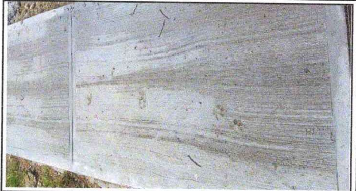
Foto 8: Reparación de banquetas de concreto.
