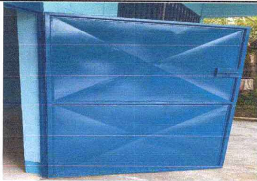
Foto 3: Mantenimiento a estructura (lijado, cambio de tubo, cepillado, sujeciones, aplicación de pintura).
