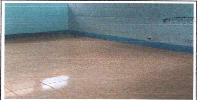
Foto 6: Sustitución de piso cerámica.
