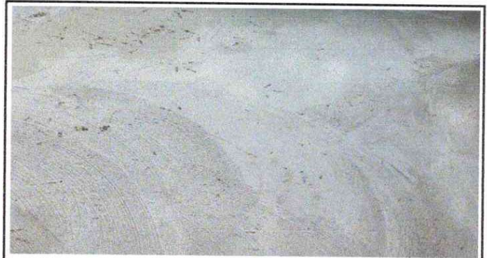
Foto 10: Sustitución de piso torta de concreto.
