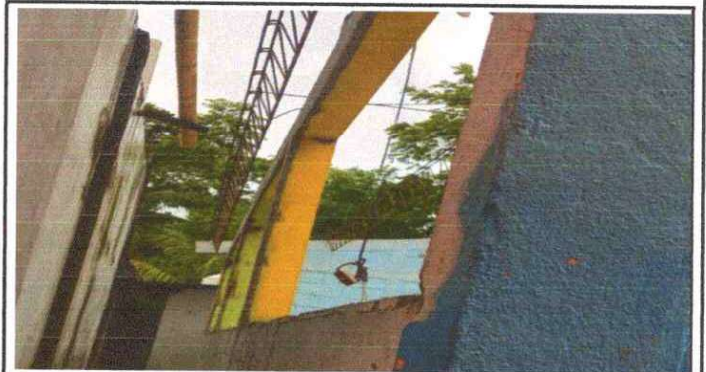
Foto 4: Sustitución de estructura de metal de ventana
