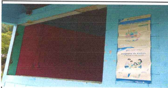
Foto 5: Sustitución de vidrios.
