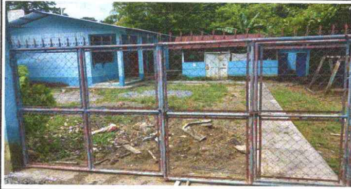
Foto 7: Mantenimiento a portones de metal.
