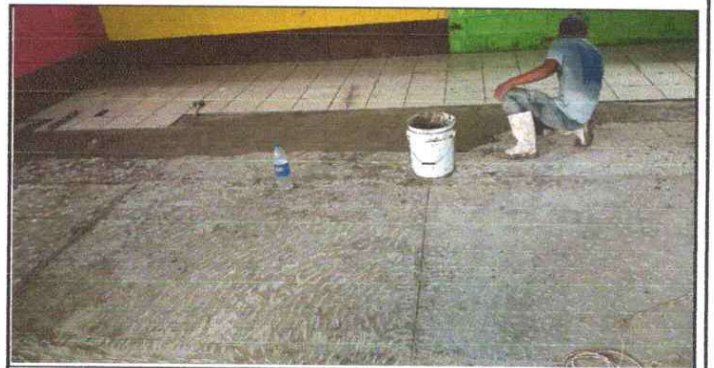
Foto 6: Sustitución de piso cemento liquido.
