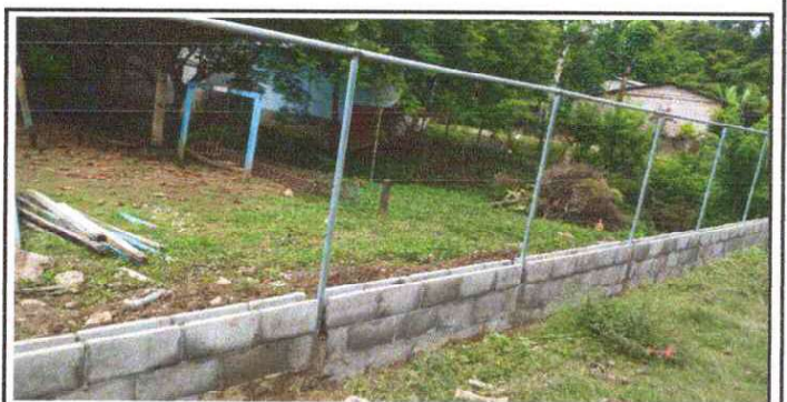
Foto 12: Reparación de muro perimetral de block
