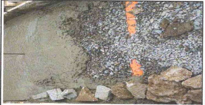
Foto 8: Reparación de banquetas de concreto.
