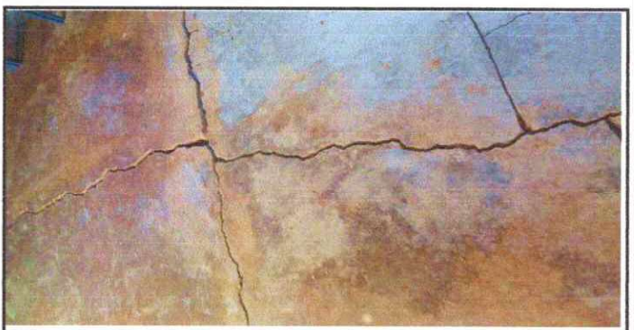
Foto 6: Sustitución de piso cerámico.
