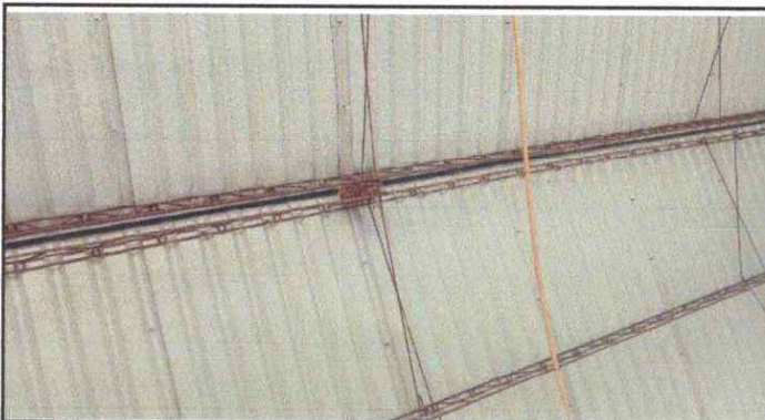
Foto 9: Reparación de cableado eléctrico.
