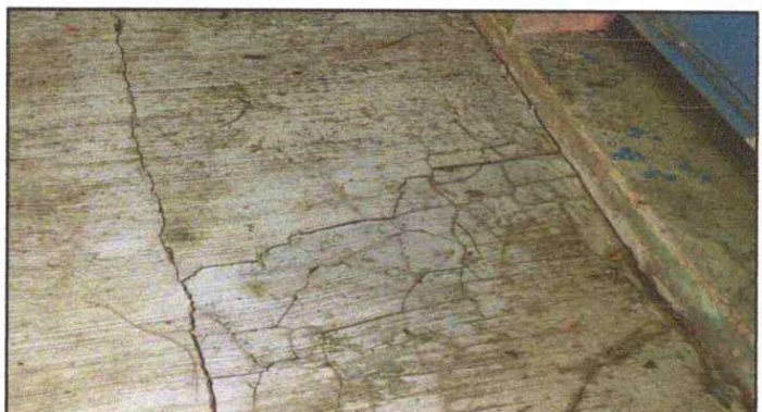
Foto 10: Sustitución de piso torta de concreto.
