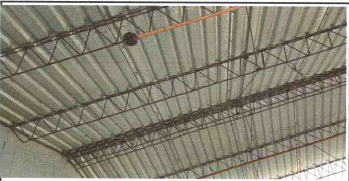
Foto 11: Sustitución de capote de lámina para lamina troquelada.
