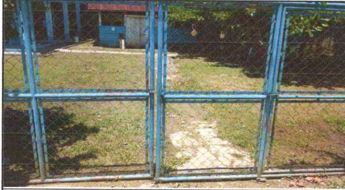
Foto 7: Mantenimiento a portones de metal.
