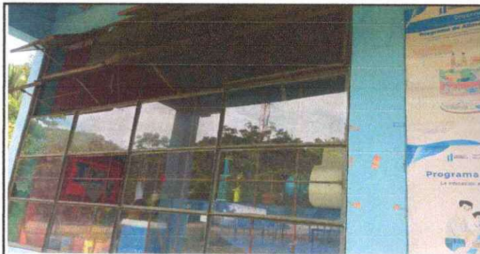
Foto 5: Sustitución de vidrios.
