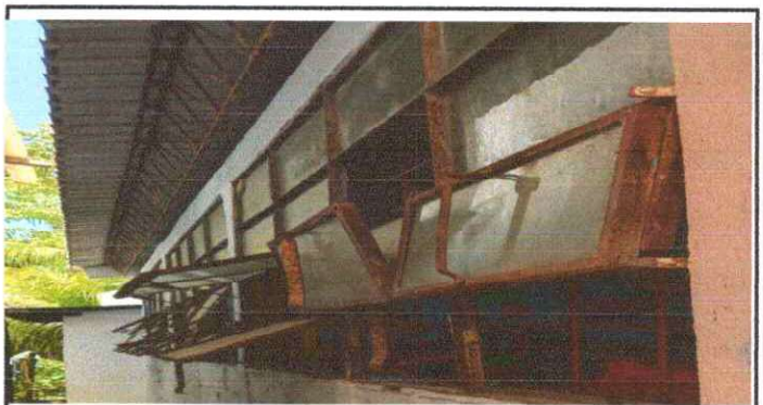
Foto 4: Sustitución de estructura de metal de ventana
