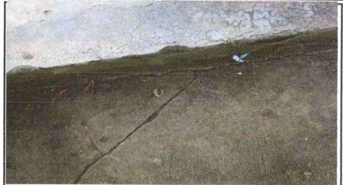
Foto 8: Reparación de banquetas de concreto.
