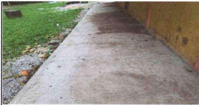
Foto 5: sustitucion de torta de cmento corredor y direccion
