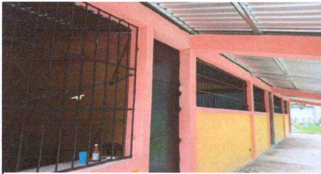
Foto 3: sustitucion de estructura soporte de metal por metal
