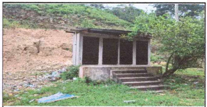
Foto 6: frabricacion e instalacin de puertas de metal de baño
