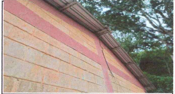
Foto 2: sustitcion de lamina troquelada
