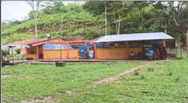
Foto1: sustitucion de lamina troquelada aluzinc calibre 25 sustitucion elementos de fijacion
