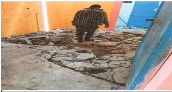
Foto 5: sustitucion de torta de cemento corredor y direccion
