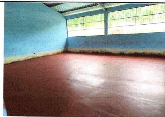
Foto 4: Reparación de piso torta de concreto, salon de clases.
