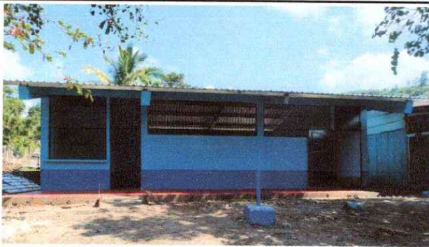
Foto 5: Vista frontal del centro educativo con las reparaciones
