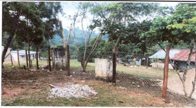
Foto 3: Reparación de cerco perimetral de alambre de pua.
