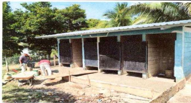
Foto 5: colocación de torta de cemento en los baños.
