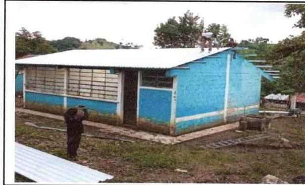
Foto1: colocación de costaneras galvanizada, colocación de techo.
