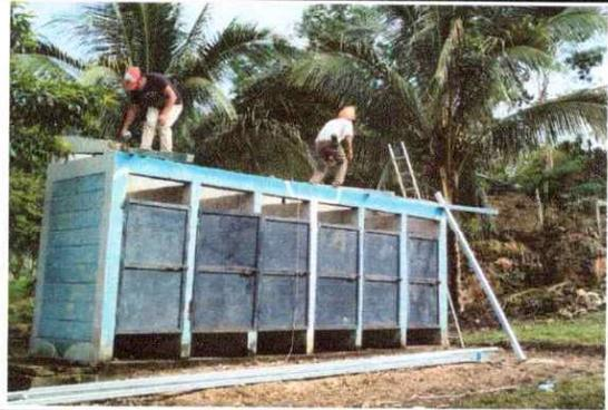
Foto 2: colocación de estructura galvanizada para el techo de los baños del centro educativo.
