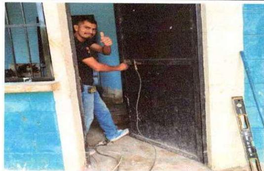
Foto 6: colocación de chapa a la puerta de la dirección.
