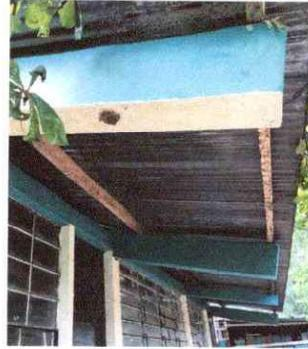
Foto 2: En la evidencia se observa como los padres de familia han sustituido con madera algunas constaneras de metal que se han deteriorado.
