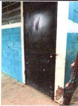
Foto 3: Se observa una de las puertas de la escuelita, en la parte inferior deteriorada.
