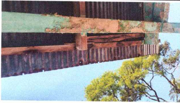
SUSTITUCIÓN DE ESTRUCTURA DE TECHO DE MADERA POR METAL
