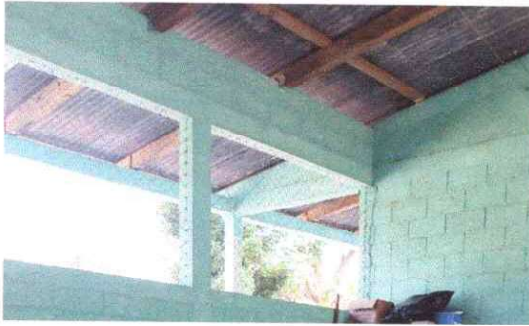
SUSTITUCIÓN E INSTALACIÓN DE MALLA METÁLICA
