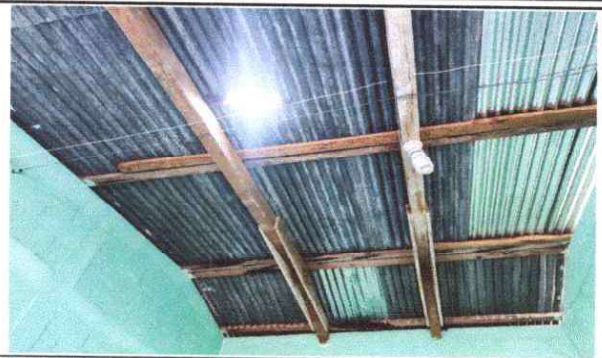
SUSTITUCIÓN DE LÁMINA POR LÁMINA GALVANIZADA ALUZINC
