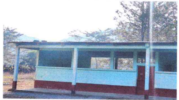
SUSTITUCIÓN E INSTALACIÓN DE MALLA METÁLICA
