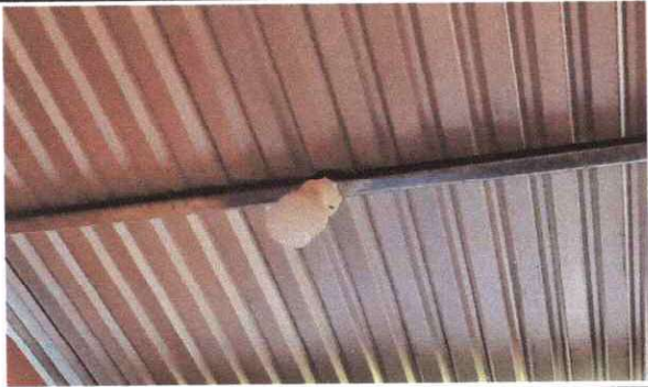
Foto 7: Sustitución de lamparas tipo LED
