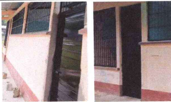
Foto 2: Sustitución de Puerta de Metal
