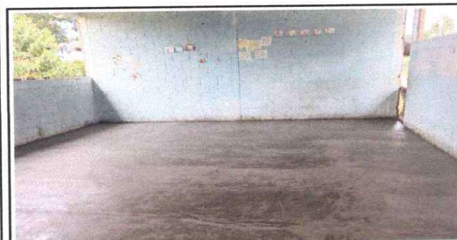
Foto 5: Reparación de torta de concreto
