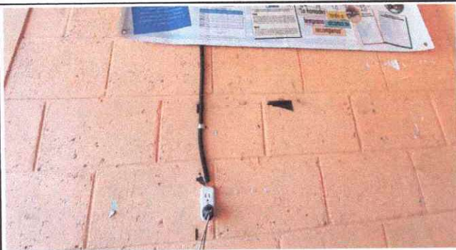
Foto 9: Sustitución de tomacorrientes dobles
