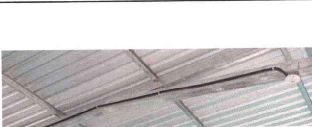
Foto 6: Sustitución de Plafoneras
