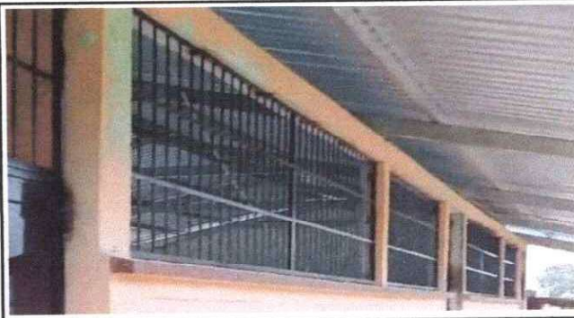
Foto 4: Sustitución de balcones de metal
