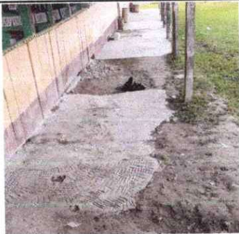
Foto 5: Reparación de torta de concreto
