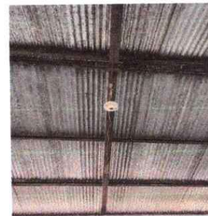
Foto 6: Sustitución de Plafoneras
