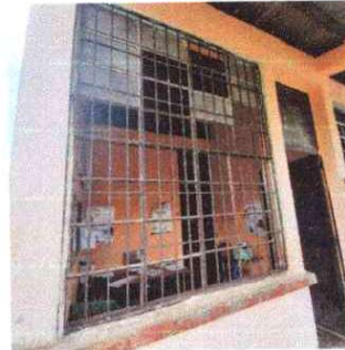
Foto 4: Sustitución de balcones de metal
