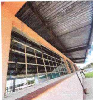
Foto 3: Sustitución de estructura de soporte de metal, por metal
