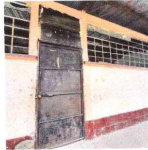
Foto 2: Sustitución de Puerta de Metal
