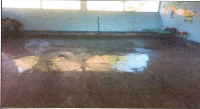
Foto 1: Sustitución TORTA DE CEMENTO LIQUIDO
