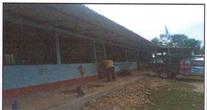
Foto 4: sustitución de balcones de metal
