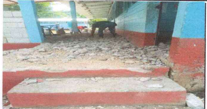
Foto 2: sustitucion de torta de cemento corredor
