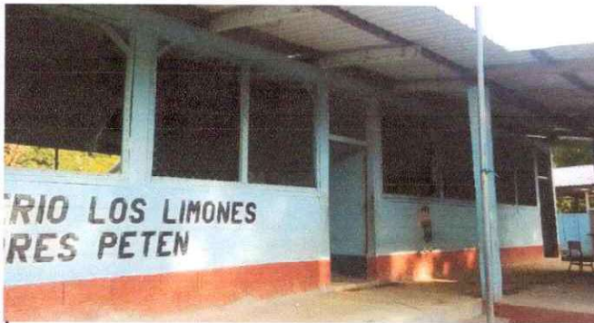
Foto 3: sustitución de puerta de metal
