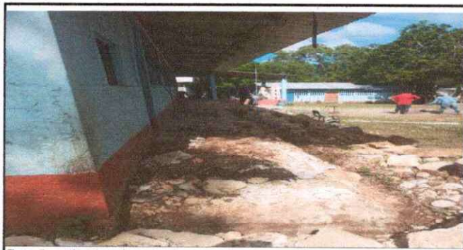
Foto 5: sustitucion de torta de concreto
