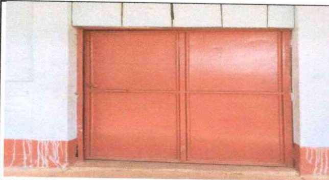
Foto 3: sustitución de puerta de metal
