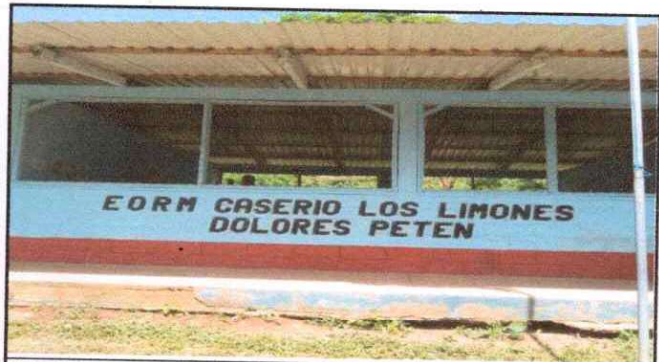
Foto 4: sustitución de balcones de metal
