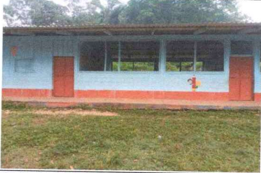
Foto 1: Sustrucion de elementos de fijacion.
