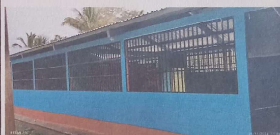
Foto 4: SUSTITUCION DE ESTRUCTURA DE METAL DE VENTANA
