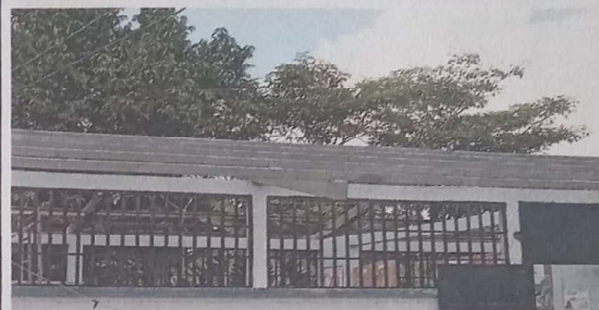
Foto 2: MANTENIMIENTO DE ESTRUCTURA PORTANTE DE METAL
