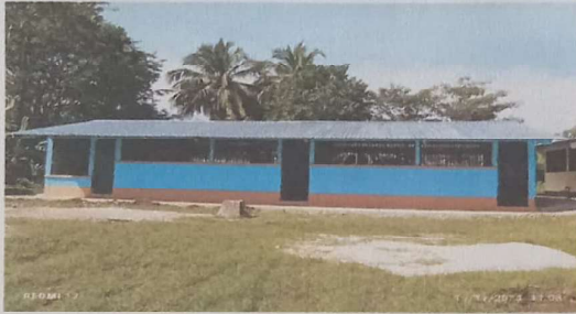
Foto 1: SUSTITUCION DE LAMINA POR LAMINA TROQUELADA ALUZING CALIBRE 26
