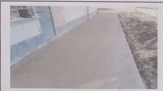
Foto 6: SUSTITUCION DE TORTA DE CONCRETO DE BANQUETA
