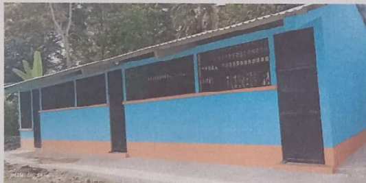
Foto 3: PINTURA EN MUROS INTERIORES Y EXTERIORES
