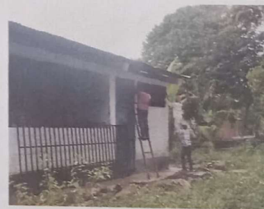
SUSTITUCION DE ESTRUCTURA DE VENTANA
