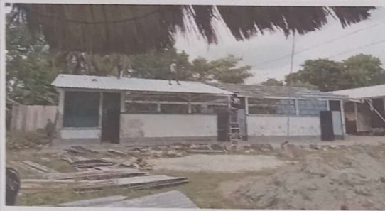
Foto1: SUSTITUCION DE LAMINA POR LAMINA TROQUELADA
