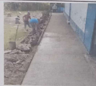
Foto 6: Remozamiento de Vanqueta
