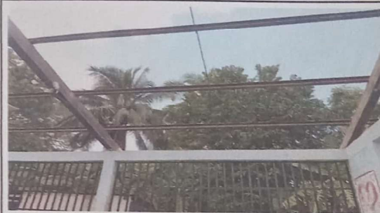
MANTENIMIENTO DE ESTRUCTURA PORTANTE DE METAL
