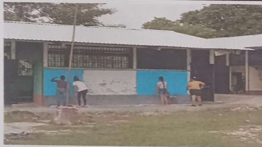
Foto 3: PINTURA EN MUROS INTERIORES Y EXTERIORES
