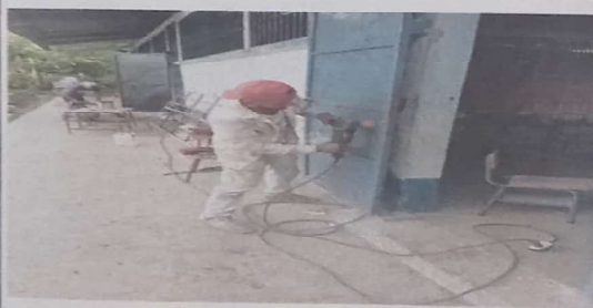
Foto 6: MANTENIMIENTO DE PUERTAS DE METAL
