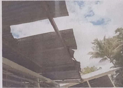
Foto 2: Mantenimiento de estructura de metal
