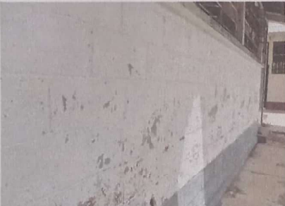
Foto 3: Pintura en muros exteriores e interiores
