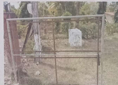
Foto 6: Sustitución de portón de metal
