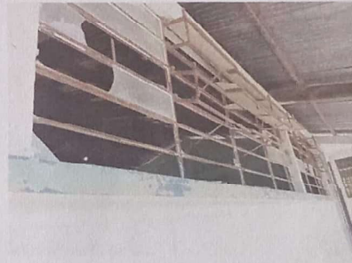
Foto 4: Sustitución de estructura de ventanas
