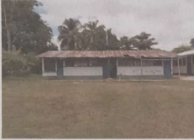
Foto1: Sustitución de lámina por lámina troquelada calibre 26
