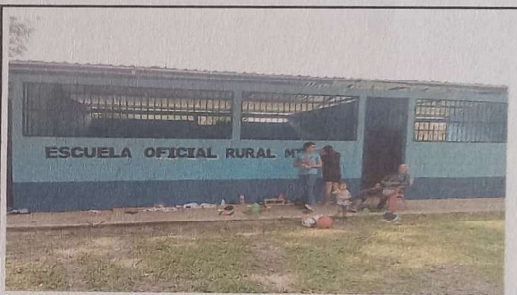
Foto 4: SUSTITUCION DE PUERTAS
