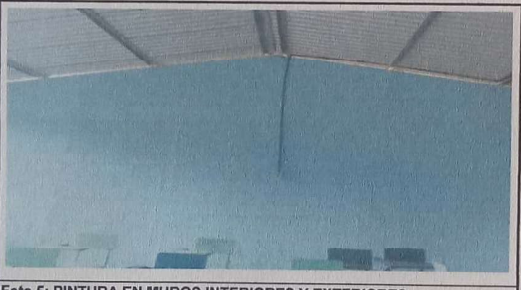
Foto 5: PINTURA EN MUROS INTERIORES Y EXTERIORES
