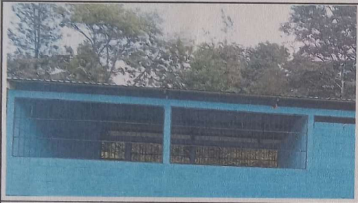
Foto 3: SUSTITUCION DE BALCONES DE METAL
