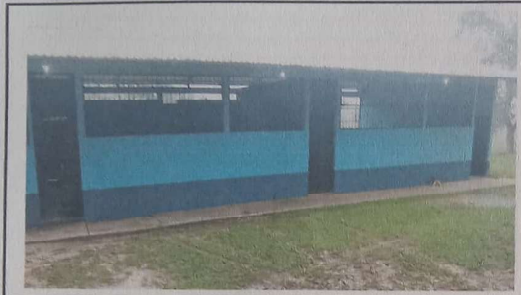
Foto 1: SUSTITUCION DE LAMINA POR LAMINA TROQUELADA
