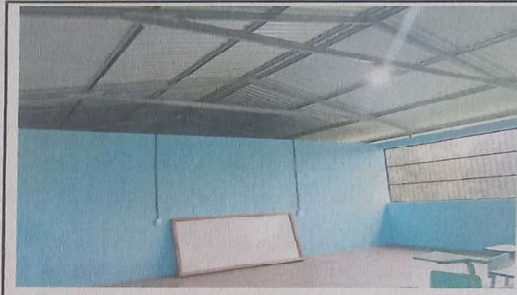
Foto 2: SUSTITUCION DE ESTRUCTURA PORTANTE DE MADERA POR METAL
