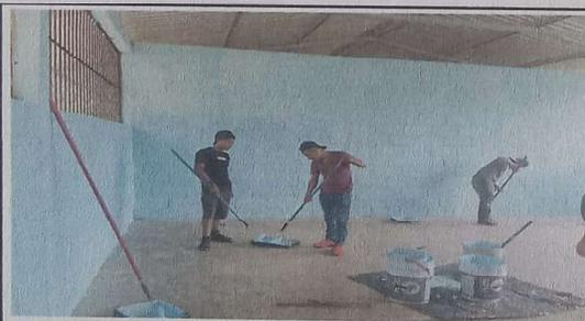
Foto 5: PINTURA EN MUROS INTERIORES Y EXTERIORES
