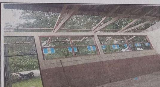
Foto 6: DESINSTALACION DE LAMINA EXISTENTE
