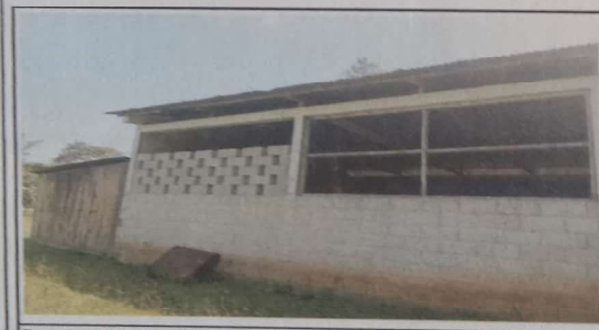
Foto 5: PINTURA EN MUROS INTERIORES Y EXTERIORES
