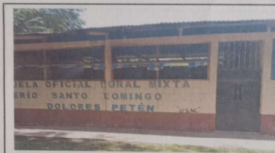
Foto 4: SUSTITUCION DE PUERTAS
