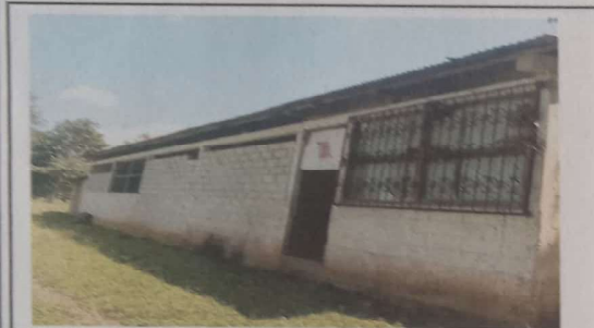
Foto 3: SUSTITUCION DE BALCONES DE METAL
