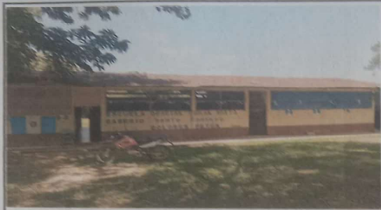
Foto 1: SUSTITUCION DE LAMINA POR LAMINA TROQUELADA
