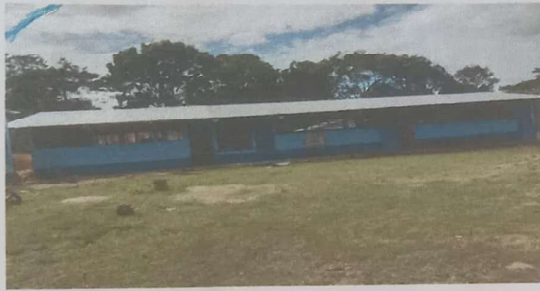
Foto 1: SUSTITUCION DE LAMINA, POR LAMINA TROQUELADA ALUZINC
