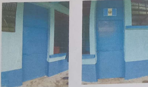
Foto 5: SUSTITUCION DE PUERTAS
