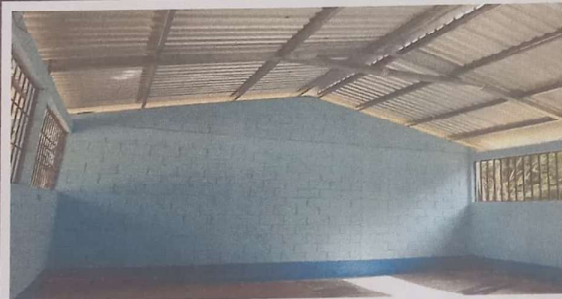
Foto 4: PINTURA EN MUROS INTERNOS Y EXTERNOS
