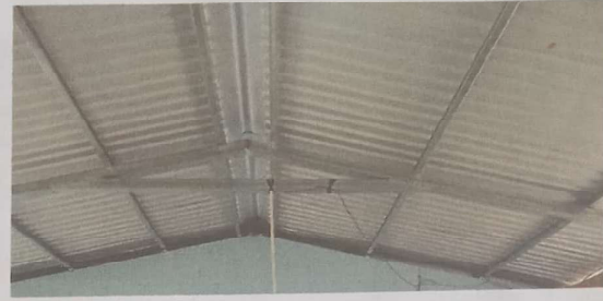
Foto 2: DESINTALACION DE ESTRUCTURA PORTANTE
