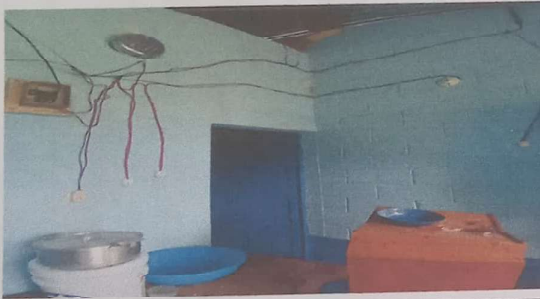
Foto 3: REPARACION DE CABLEADO ELECTRICO
