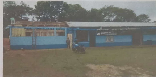
Foto 2: DESINTALACION DE ESTRUCTURA PORTANTE
