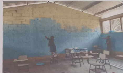
Foto 4: PINTURA EN MUROS INTERNOS Y EXTERNOS
