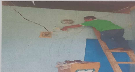
Foto 3: REPARACION DE CABLEADO ELECTRICO
