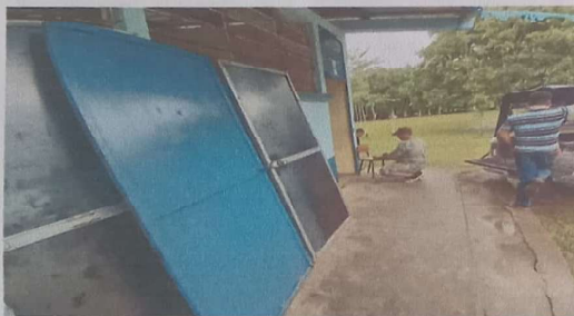
Foto 5: SUSTITUCION DE PUERTAS
