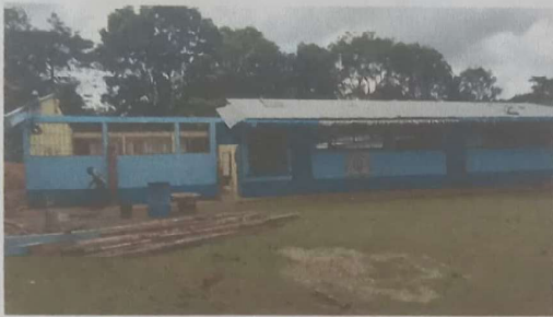
Foto 1: SUSTITUCION DE LAMINA, POR LAMINA TROQUELADA ALUZING
