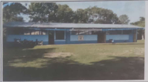
Foto1: SUSTITUCION DE LAMINA, POR LAMINA TROQUELADA ALUZINC
