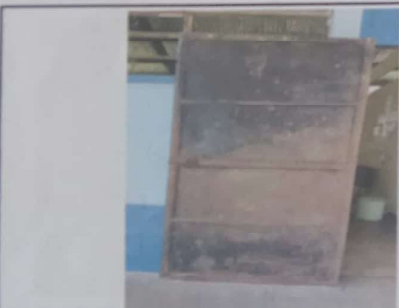
Foto 5: SUSTITUCION DE PUERTAS
