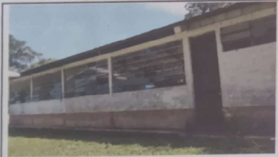
Foto 3: PINTURA EN MUROS INTERIORES Y EXTERIORES
