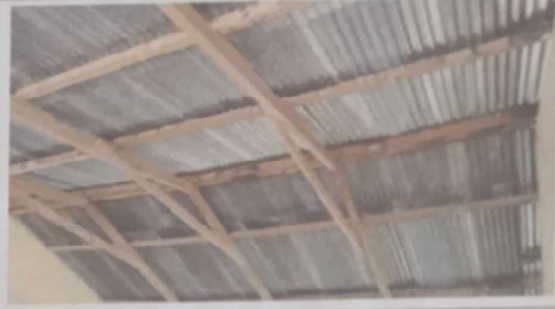
Foto 2: DESINSTALACION DE ESTRUCTURA PORTANTE
