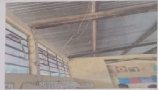
Foto 4: REPARACION DE CABLEADO ELECTRICO
