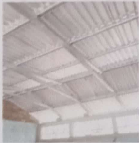
Foto 3: Sustrucción de lámina, por lámina troquelada aluzinc calibre 26
