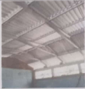
Foto 1: Sustrucción de estructura de soporte de madera, por metal.
