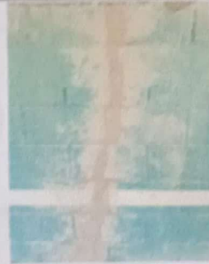
Foto 2: Sellado de grietas y fisuras en muros.
