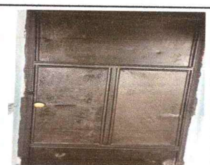
Foto 12, Cambio de chapas
