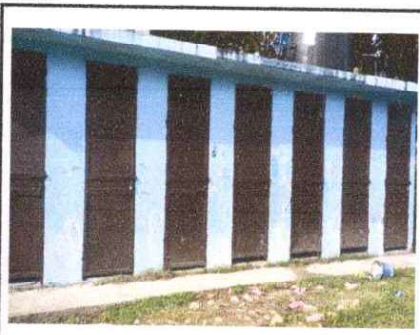
foto 7 Puertas de sanitarios
