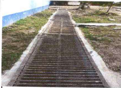
Foto 3: Cuneta de concreto
