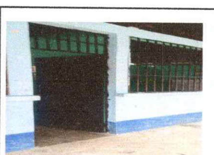
Foto 12, Cambio de chapas
