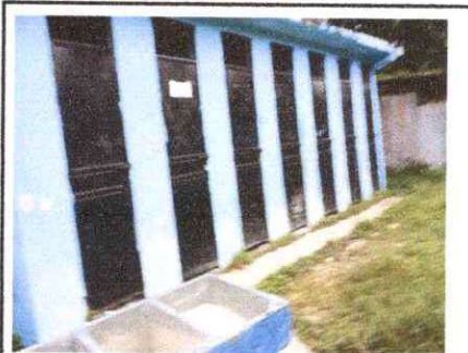
foto 10 Puertas de sanitarios
