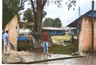
Foto 2: Porton y muro perimetral.
