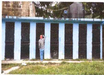
Foto 5: Puertas de sanitario
