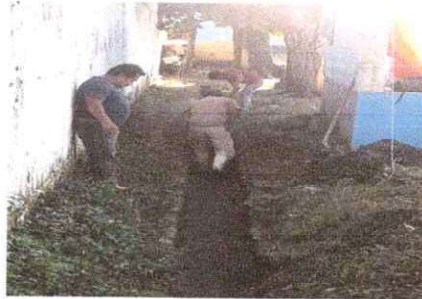
Foto 3: Cuneta de concreto
