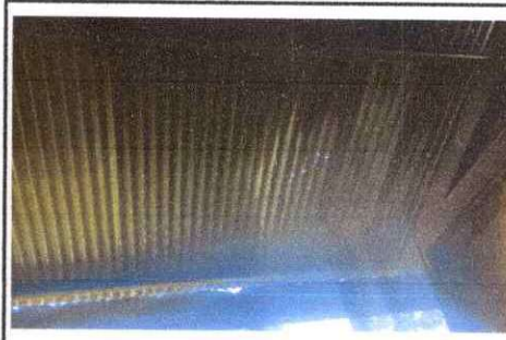
Foto 6: Lamina de cocina
