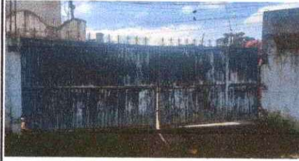
Foto 1: Portón de ingreso, lado este.
