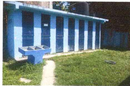
Foto 5: Puertas de sanitario
