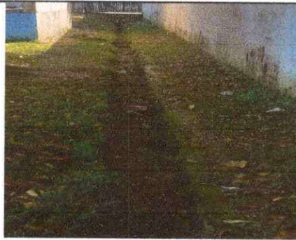
Foto 3: Cuneta de concreto
