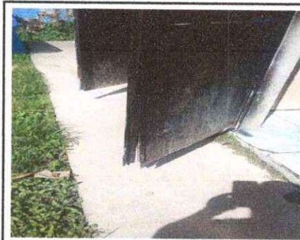
foto 10 Puertas de sanitarios
