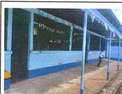
Foto 12, Cambio de puerta
