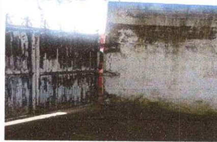
Foto 2: Portón y muro perimetral.
