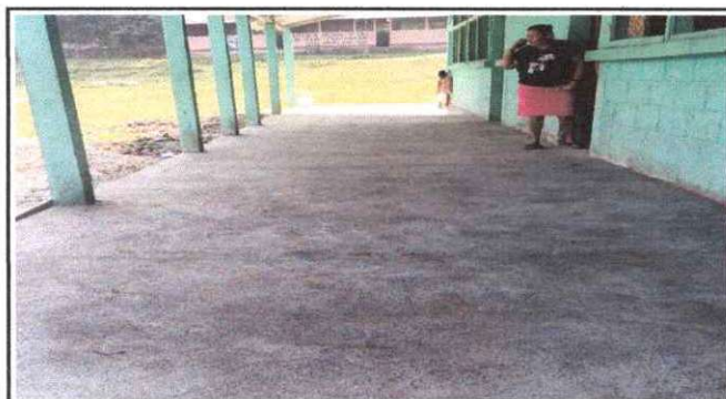
Foto 3: Sustitución de Piso de Torta de Concreto
