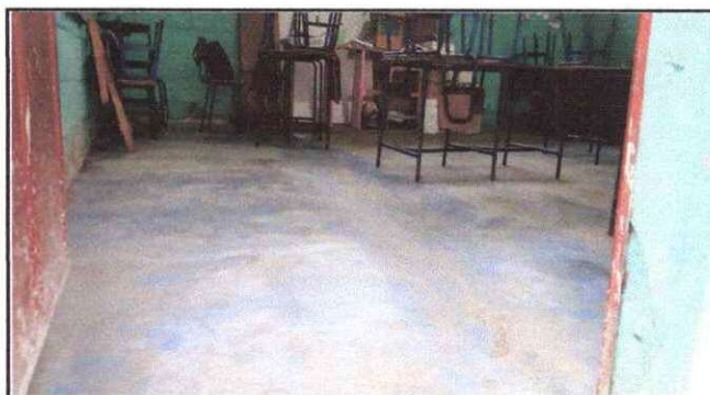
Foto 4: Sustitución de Piso de Cemento Líquido
