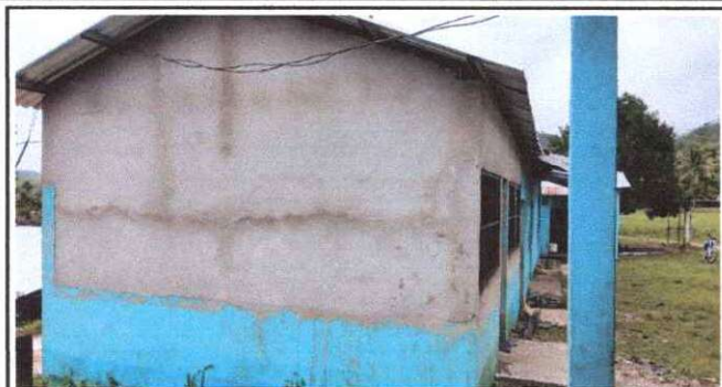
Foto 1: Sustitución de Pared
