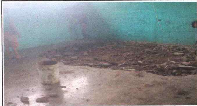
Foto 4: Sustrucción de Piso de Cemento Liquido
