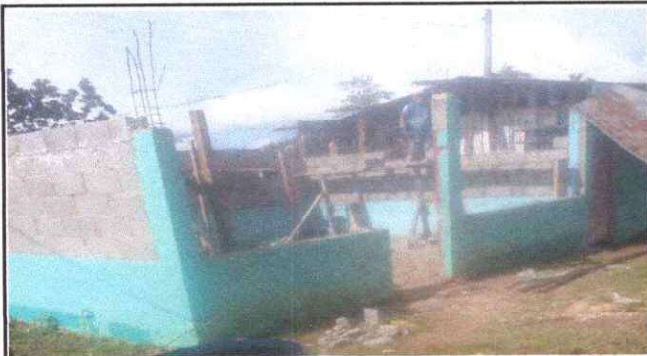
Foto 1: Sustrucción de Pared y Balcones de Metal
