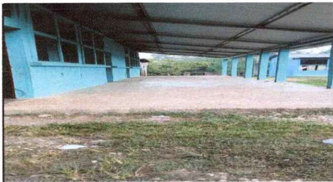
Foto 3: sustitución de piso de torta de concreto
