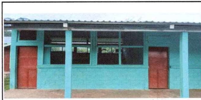
Foto 5: fabricación e instalacion de ventana balcon de metal
