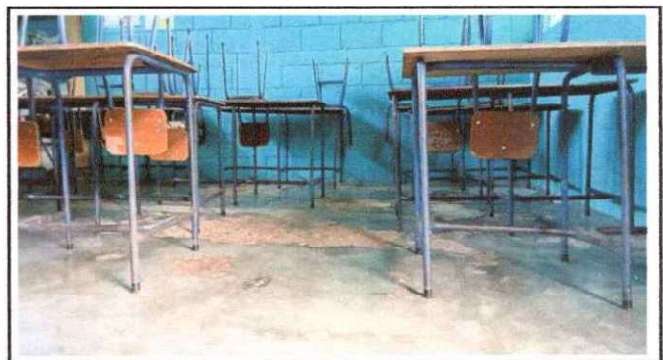
Foto 4: sustitución de piso de cemento liquido
