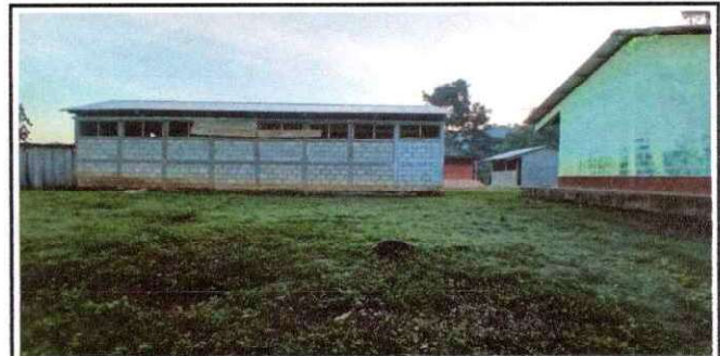
Foto 6: fabricación e instalacion de ventana balcon de metal
