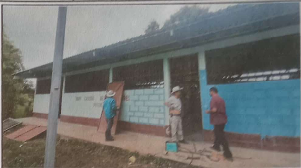
SUSTITUCION DE LAMINAS
