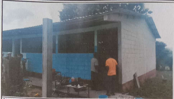
SUSTITUCION DE PUERTAS
