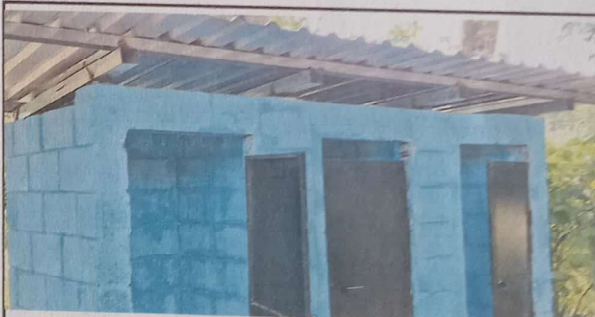
SUSTITUCION DE PUERTAS
