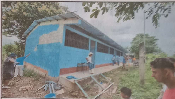
PINTURA EN MUROS INTERIORES Y EXTERIORES
