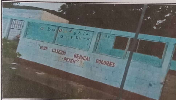
DESINSTALACION DE ESTRUCTURA
