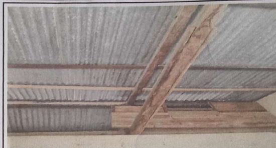
Foto 2: SUSTITUCION DE ESTRUCTURA PORTANTE DE MADERA POR METAL
