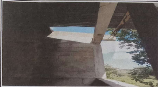
Foto 1: SUSTITUCION DE LAMINA POR LAMINA TROQUELADA
