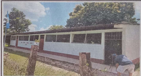
Foto 4: SUSTITUCION DE LAMINA POR LAMINA TROQUELADA
