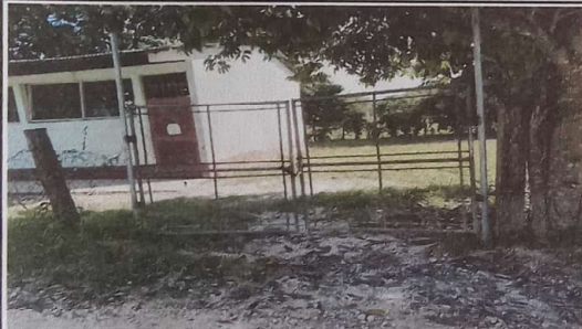
Foto 3: SUSTITUCION DE PORTON DE METAL
