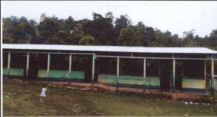
Foto 1: Sustitución de lámina por lámina galvanizada aluzinc
