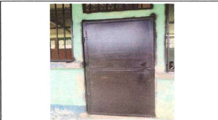
Foto 3: Sustitución de puertas de metal
