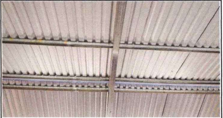
Foto 2: Sustitución de estructura de madera por metal
