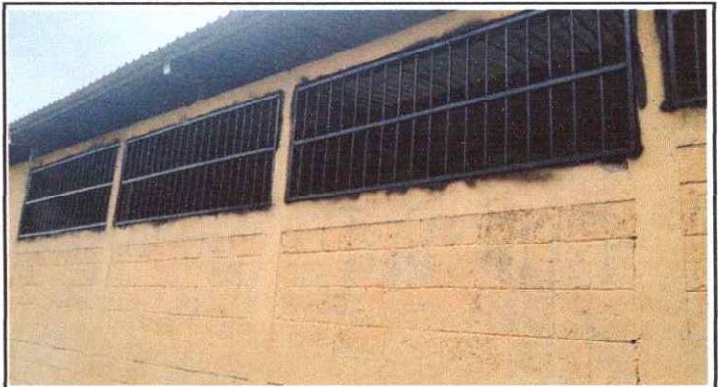
Foto 4: Sustitución de balcones de metal parte trasera
