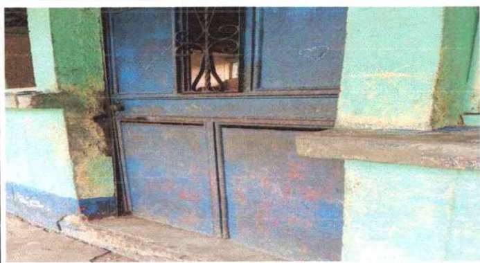
Foto 3: sustitucion de puerta de metal de aulas
