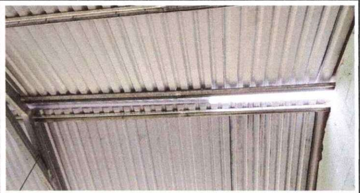
Foto 2: Sustitución de estructura de techo de madera por metal
