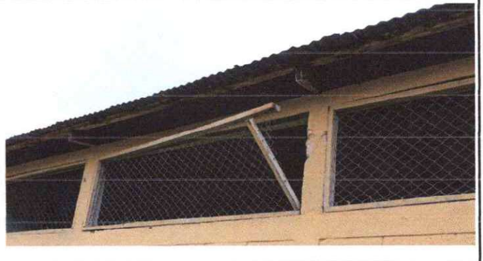
Foto 4: Sustitucion de marcos de madera por metal de ventanas
