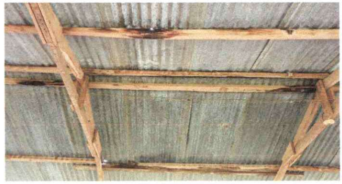
Foto 2: Sustitucion de Estructura de techo de madera por metal
