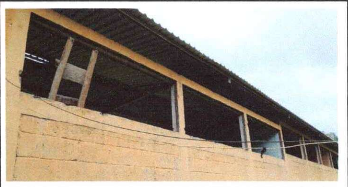
Foto 4: Sustitución de balcones de madera por metal de ventanas
