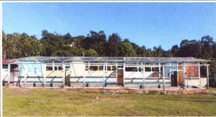
Foto1: Sustitución de lámina por lámina galvanizada aluzinc
