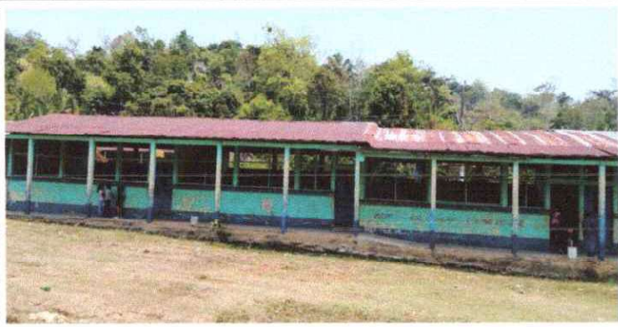
Foto1: Sustitucion de lámina por lamina galvanizada aluzinc
