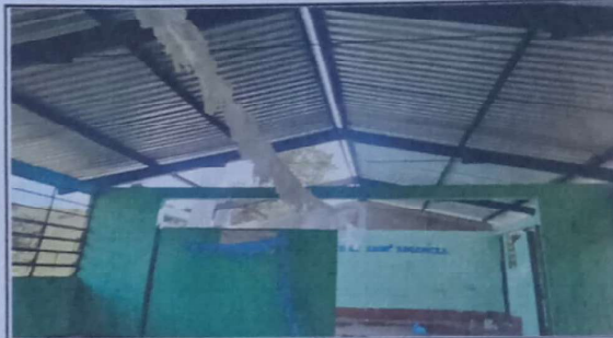
Foto 2: MANTENIMIENTO A ESTRUCTURA DE SOPORTE DE METAL
