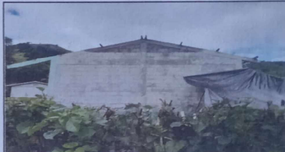
Foto 4: PINTURA EN MUROS INTERIORES Y EXTERIORES
