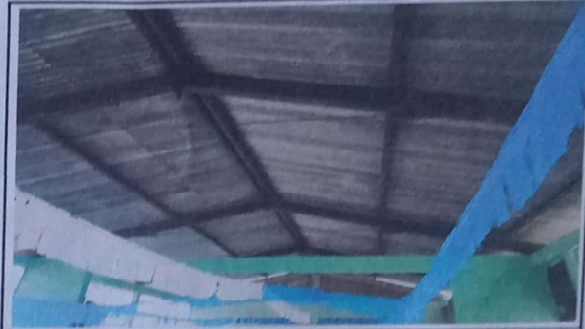
Foto 2: MANTENIMIENTO A ESTRUCTURA DE SOPORTE DE METAL
