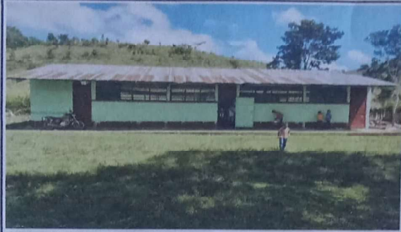
Foto1: SUSTITUCIÓN DE LAMINA, POR LAMINA TROQUELADA ALUZING CALIBRE 26
