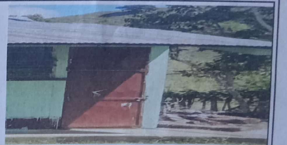
Foto 6: MANTENIMIENTO A ESTRUCTURA ( LIJADO, CAMBIO DE TUBO, CEPILLADO, APLICACIÓN DE PINTURA
