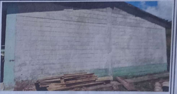
Foto 4: PINTURA EN MUROS INTERIORES Y EXTERIORES
