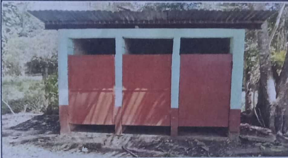
Foto 3: SUSTITUCION DE ESTRUCTURA DE SOPORTE DE METAL POR METAL
