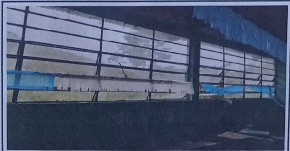
Foto 5: MANTENIMIENTO A ESTRUCTURA DE METAL DE VENTANA
