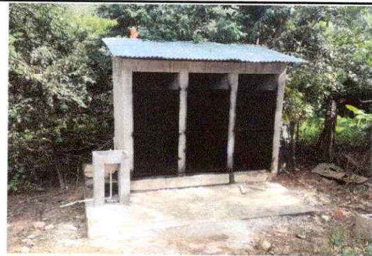
Foto 2: Colocación de puertas, en baños del establecimiento.
