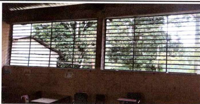
Foto 5: Balcones de una de las aulas del establecimiento.
