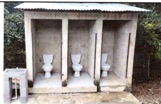
Foto 6: colocación de tazas de baño labables.
