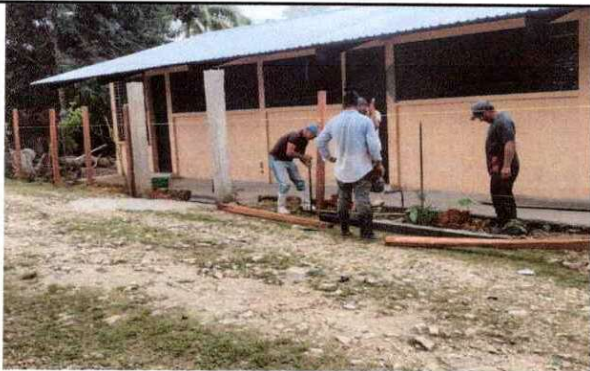
Foto 3: colocando postes para cerco de alambre de púas y malla metálica.
