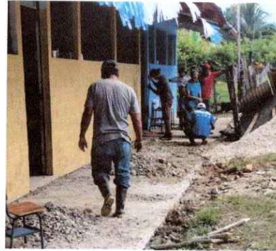
Foto 2: Demolición de piso en mal estado en el corredor del establecimiento.
