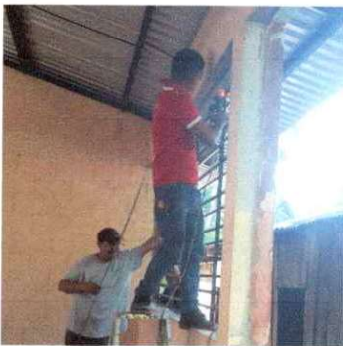
Foto 5: Colocando balcon en ventanas del aula.
