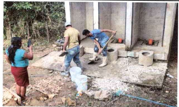
Foto 4: Reparación de piso torta de concreto, en baños del centro educativo
