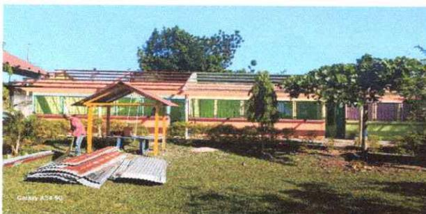
Foto 5: SUSTITUCION DE LÁMINA POR LÁMINA TROQUELADA CALIBRE 26
