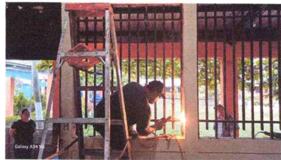
Foto 4: SUSTITUCION DE VENTANAS DE MADERA POR VENTANAS METAL MAS VIDRIO
