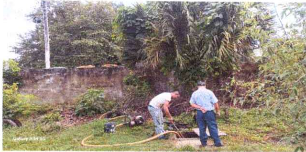
Foto1: LIMPIEZA FOS SEPTICA
