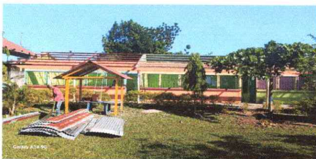
Foto 5: SUSTITUCION DE LÁMINA POR LÁMINA TROQUELADA CALIBRE 26
