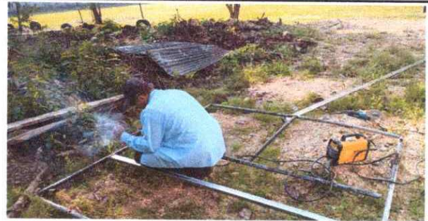
Foto 2: REPARACIÓN DEL PORTON DE METAL
